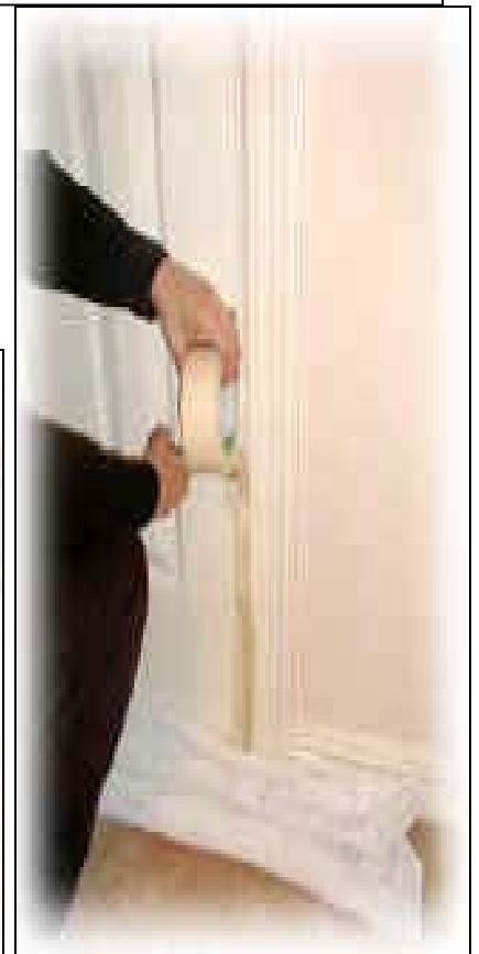
Sealing a Door Frame
